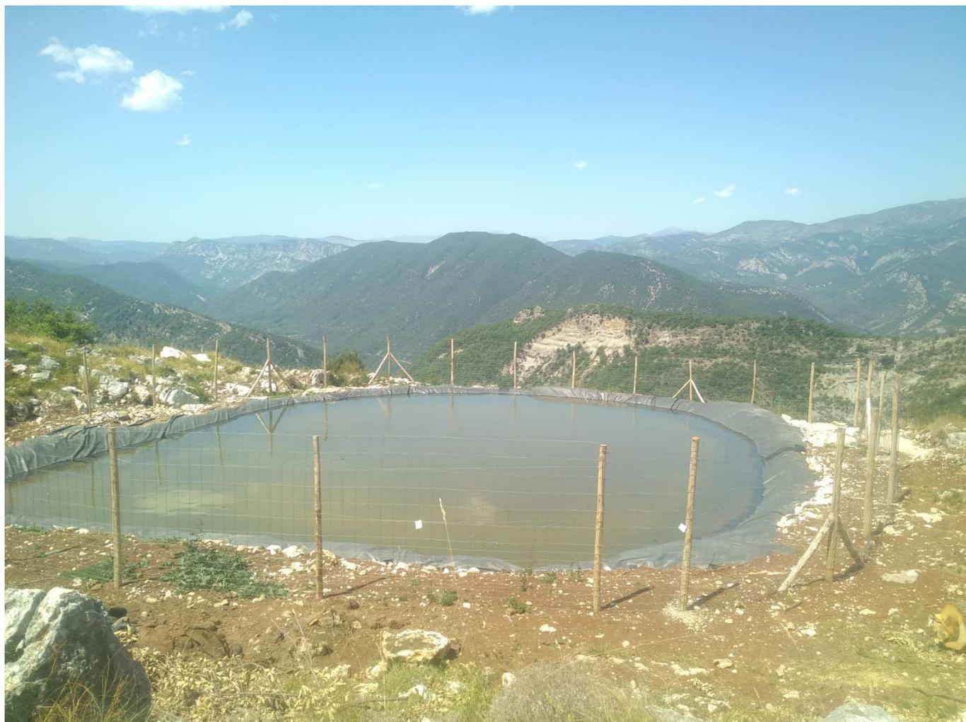
Figure 3 : Exemple de réalisation d'une retenue collinaire avec pose de grillage
