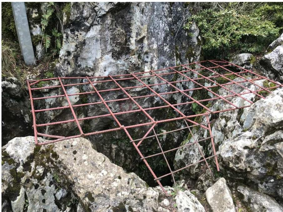
Conformément à la publication Eurobats n°2, la grille sera fabriquée avec des barreaux de 50 mm de diamètre, espacés de 170 mm et renforcée par des fers plats de 4 mm tous les 600 mm.
