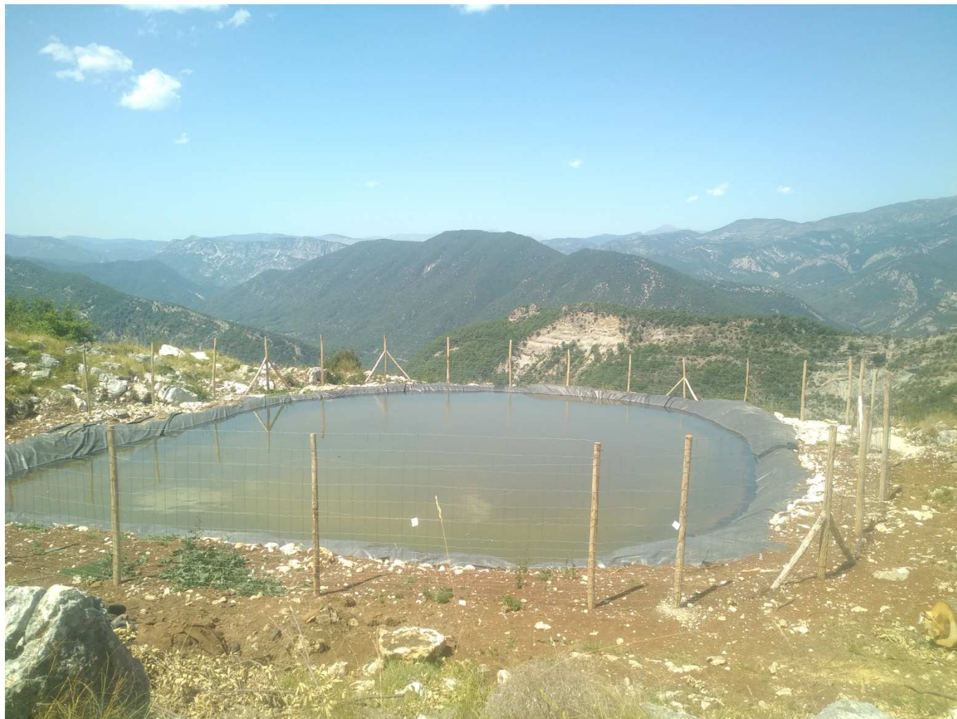
Figure 3 : Exemple de réfection de la clôture située autour d'une retenue collinaire
