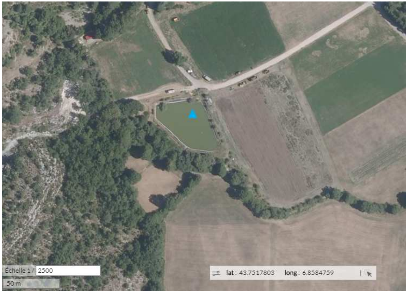
Figure 1 : Localisation de la retenue collinaire - vue aérienne – 1/2500 ème
