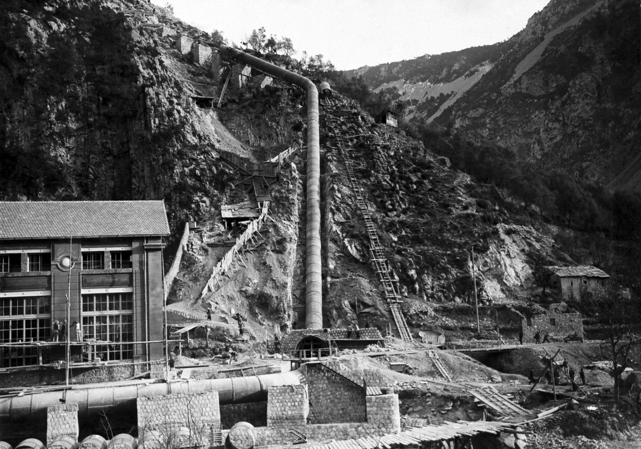
12.6 Usine hydro-électrique de Fontan en construction, 25 janvier 1914. AD06, 3Fi 10482
