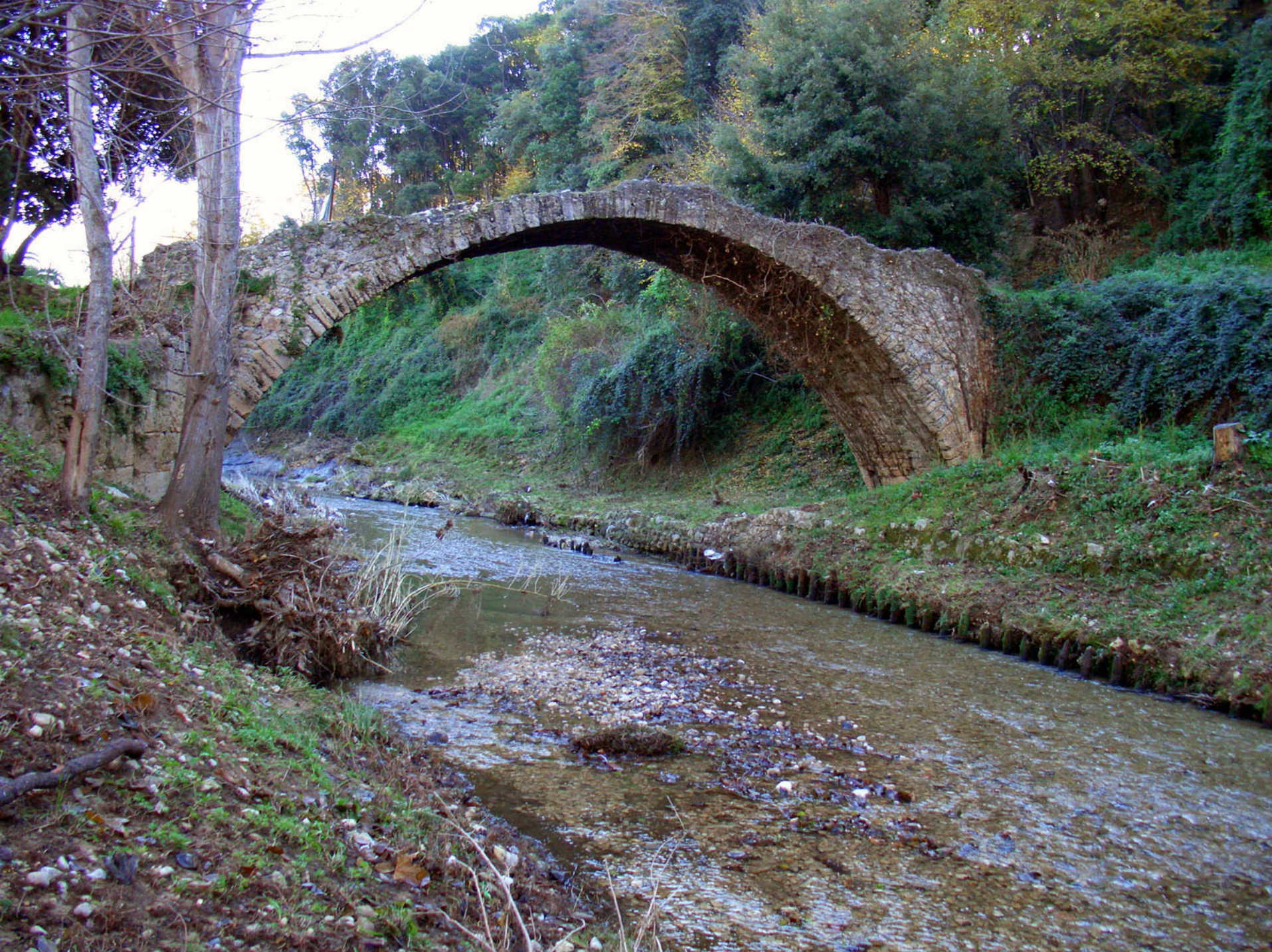
12.3 Pont sur la Brague à Biot, construit au XVIIIe siècle. AD06, photographie Jean-François Boué
