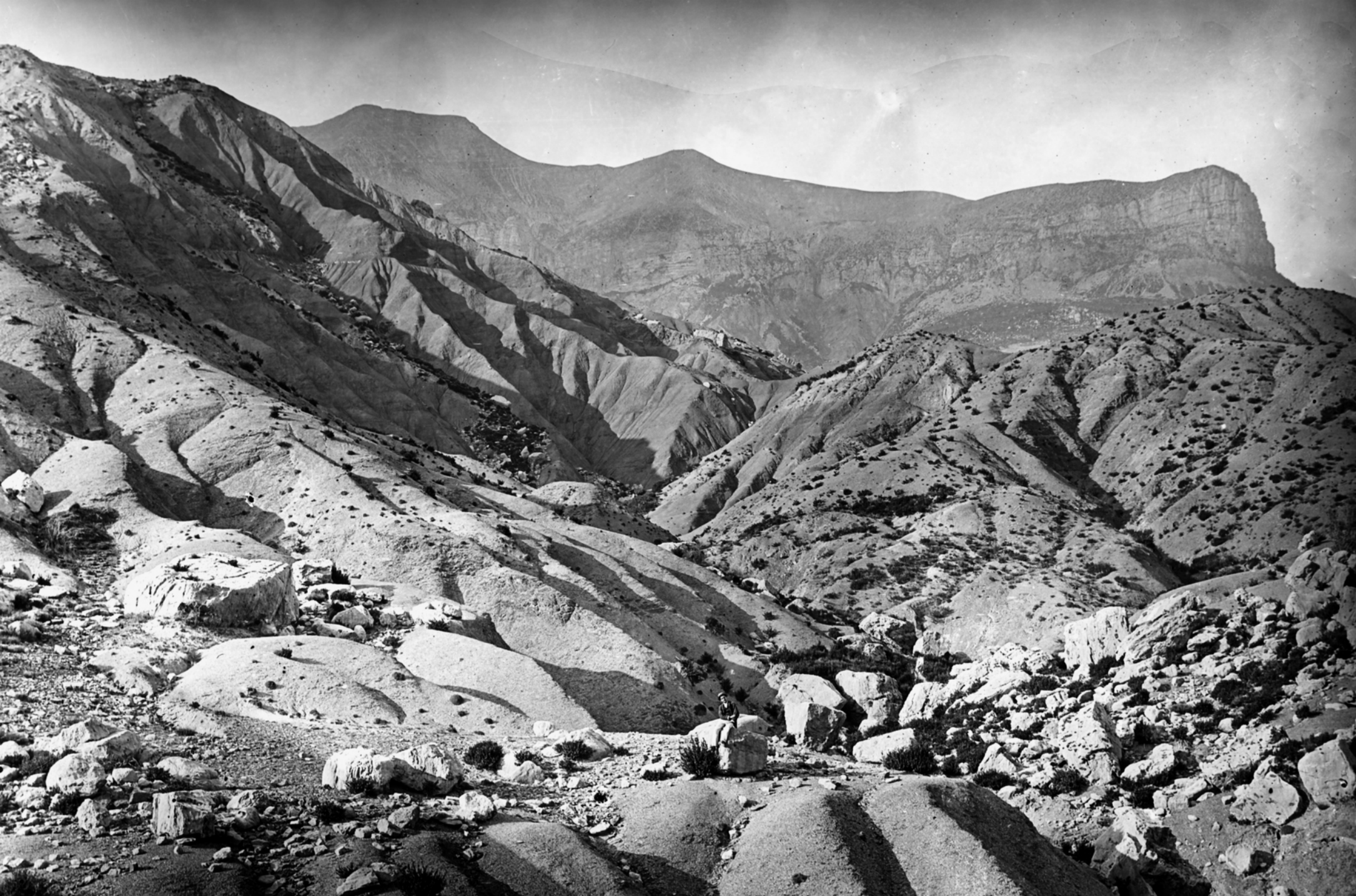
5.3 Berges éboulées du torrent de Péroucie, à Villeneuve-d'Entraunes, 1er août 1887, photographie Eaux et Forêts. 23Fi 43
