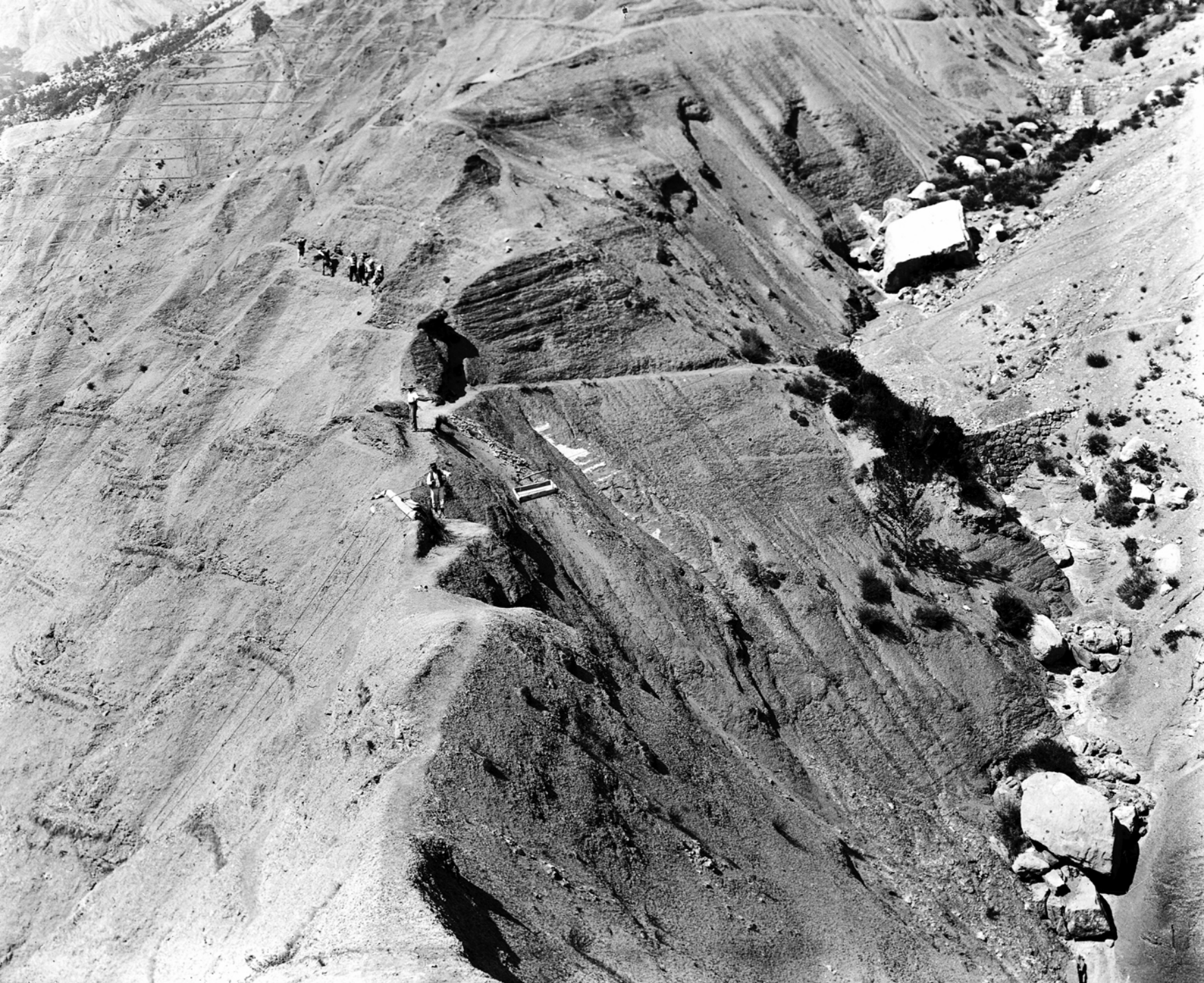
6.5 Travaux de reboisement et d'endiguement d'un torrent à Villeneuve d'Entraunes, 1er septembre 1906, photographie Eaux et Forêts. 23Fi 265
