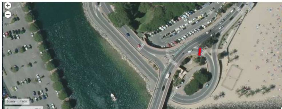
Portique léger aval Avenue de la Mer (bretelle d'accès à l'Avenue de la Mer côté mer)
