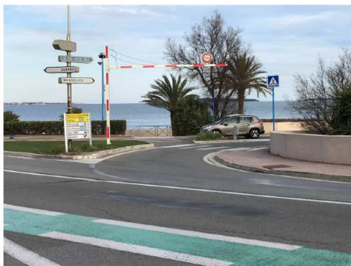
Portique léger existant bretelle d'accès Avenue de la Mer (côté Mer) – Non détérioré
