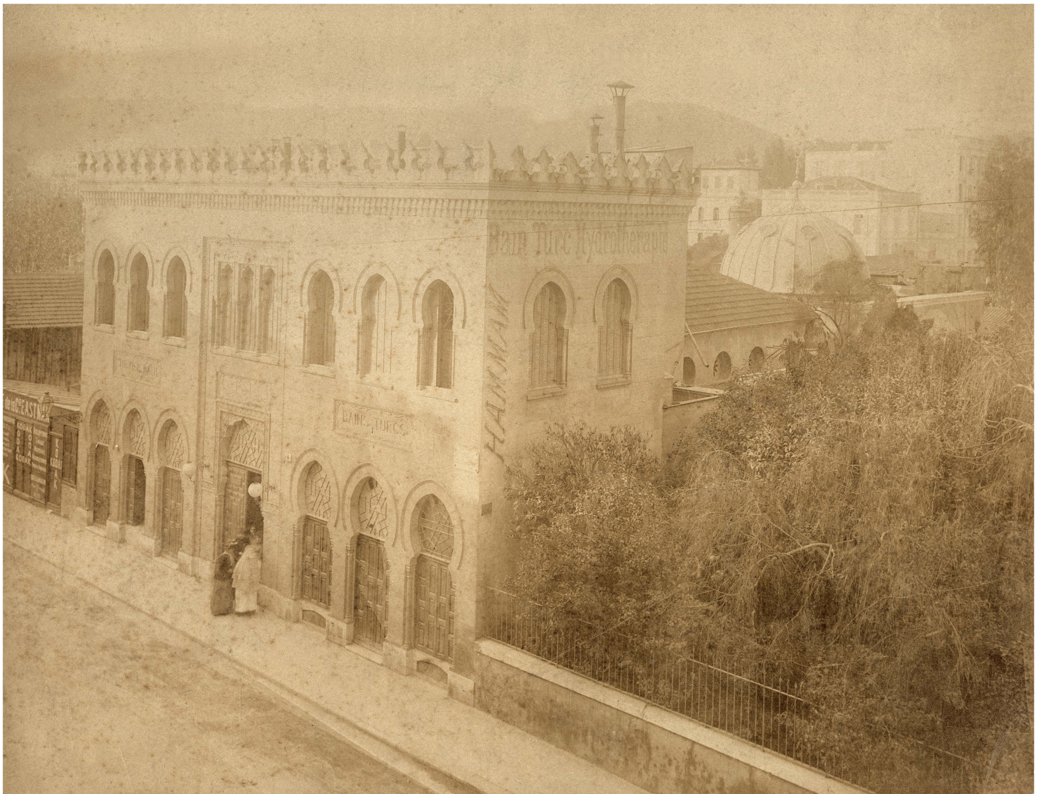
2.8 Hammam rue de la Buffa à Nice vers 1900. Arch. dép. Alpes-Maritimes, 231 J 11.
