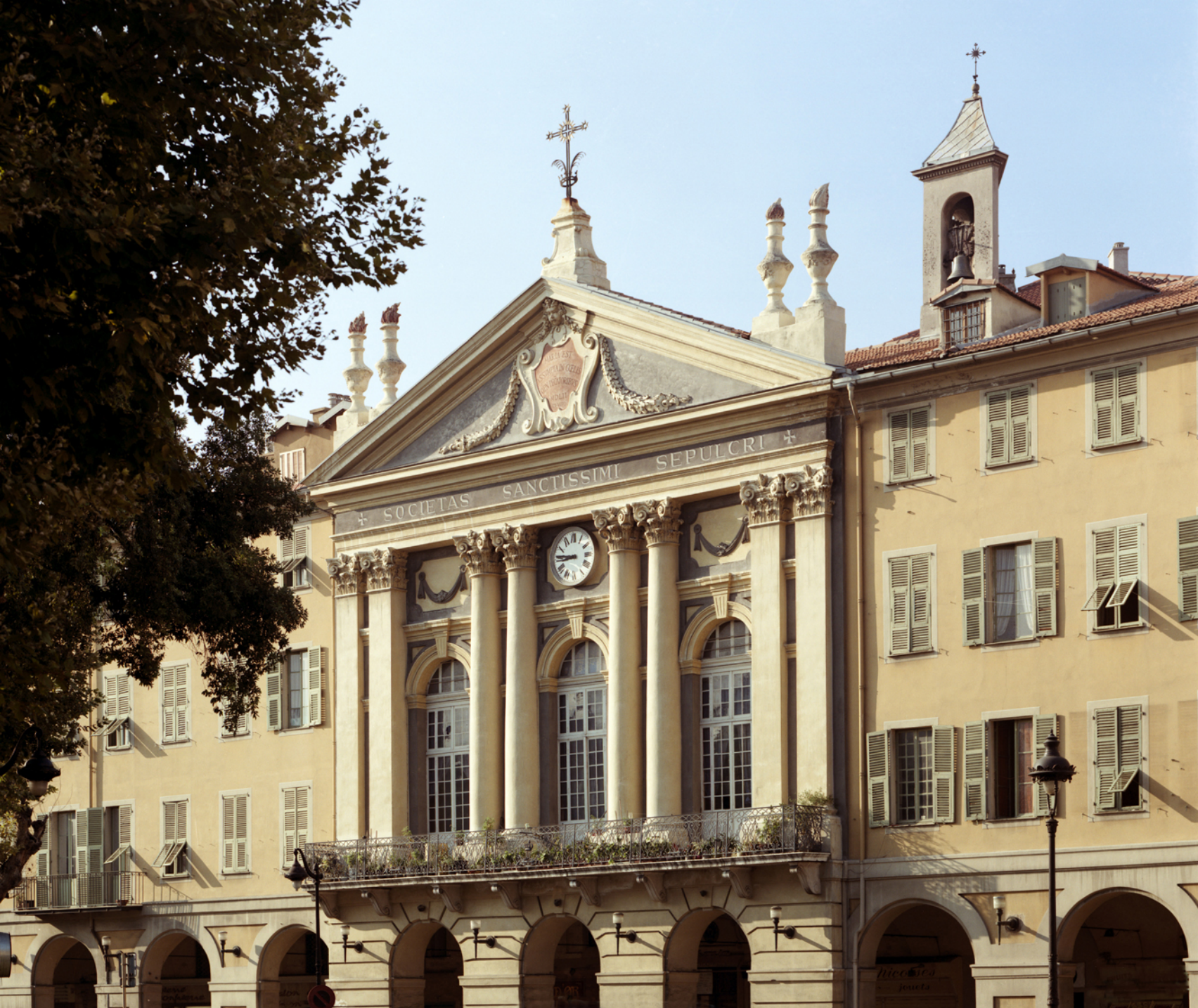
10.8 Bâtiments de la place Victor à Nice construits à la fin du XVIIIe siècle. AD06, photographie Michel Graniou
