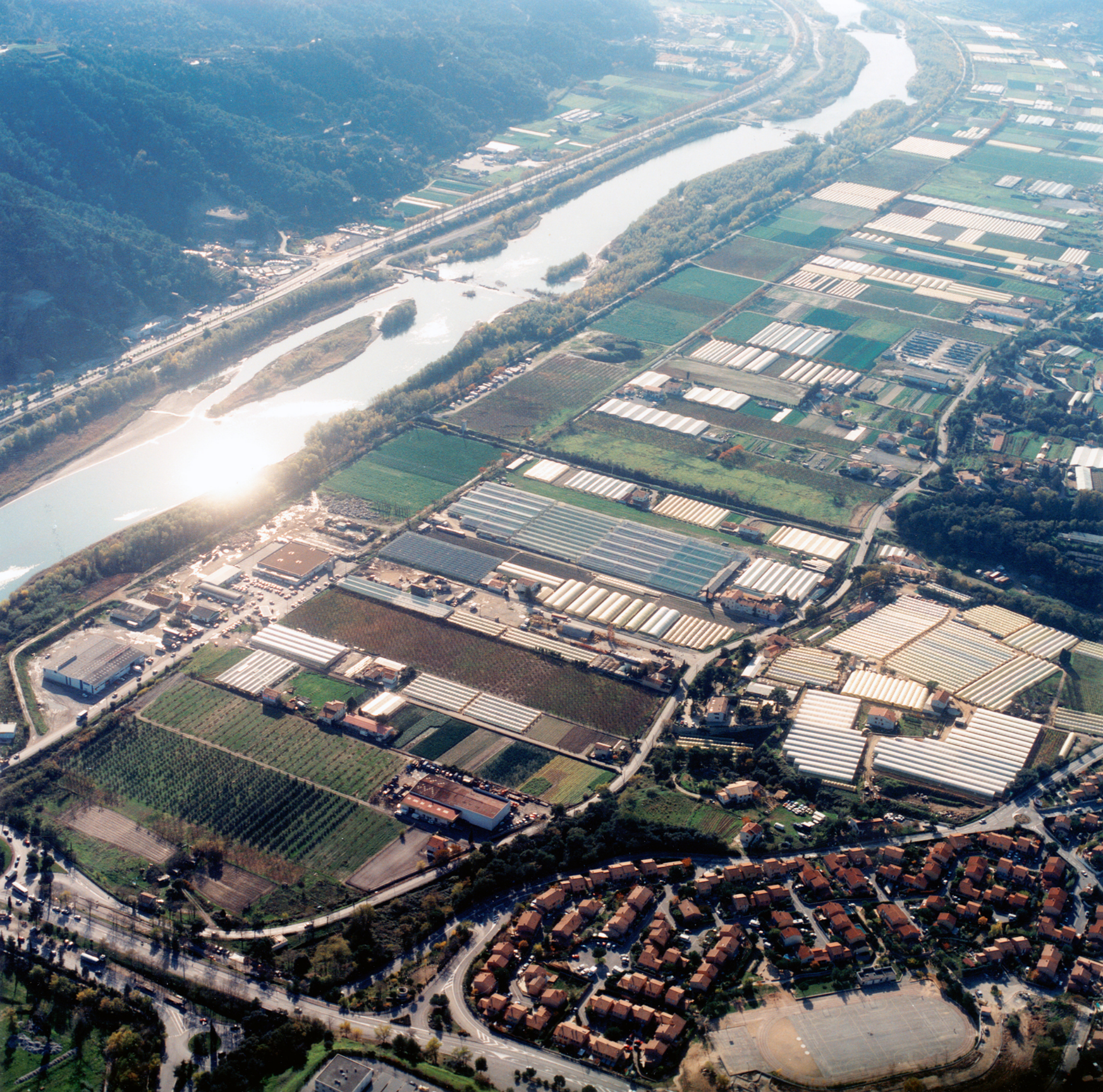
13.3 Vues aériennes des cultures maraîchères sur les terrains résultant de l'endiguement du Var, 1991, photographies Laboratoire départemental de l'Équipement. 22Fi
