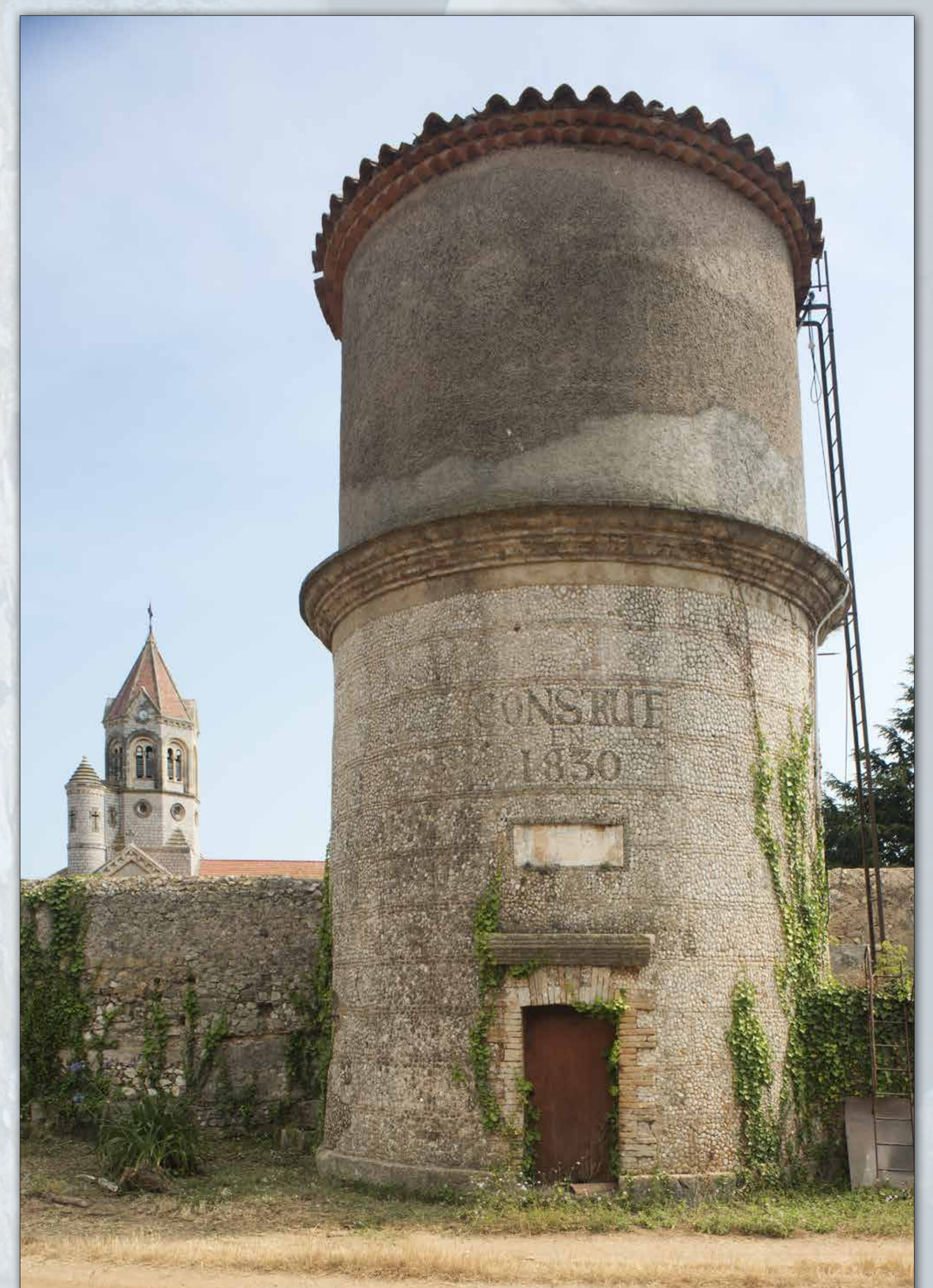
Château d'eau dit de la source de Saint-Honorat, avec parement en assemblage de galets, commandé et achevé en 1830 par Louis Sicard. Photo M. Granjou, 2017. Arch. dép. Alpes-Maritimes, 37 W.
