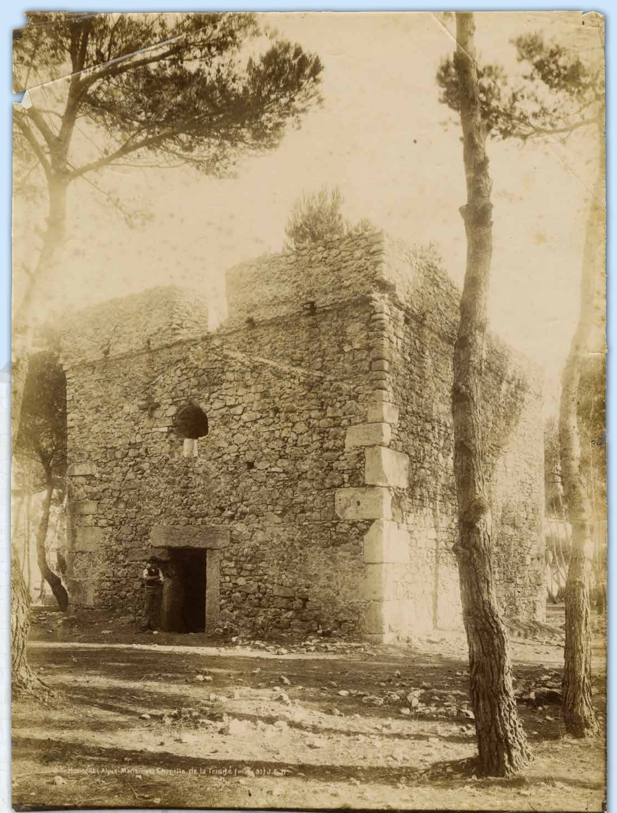
Chapelle de la Trinité, transformée en bastion par les troupes espagnoles lors de l'occupation de l'île, fin XIX e siècle années 1920. Photographie inconnue. Tirage moderne. Arch. dép. Alpes-Maritimes, 4 77,9.
