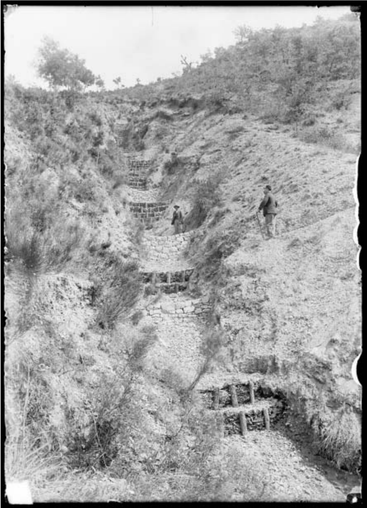
Construction de seuils sur le ravin de la Rose à Puget-Rostang, 1888 23 Fi 0533
