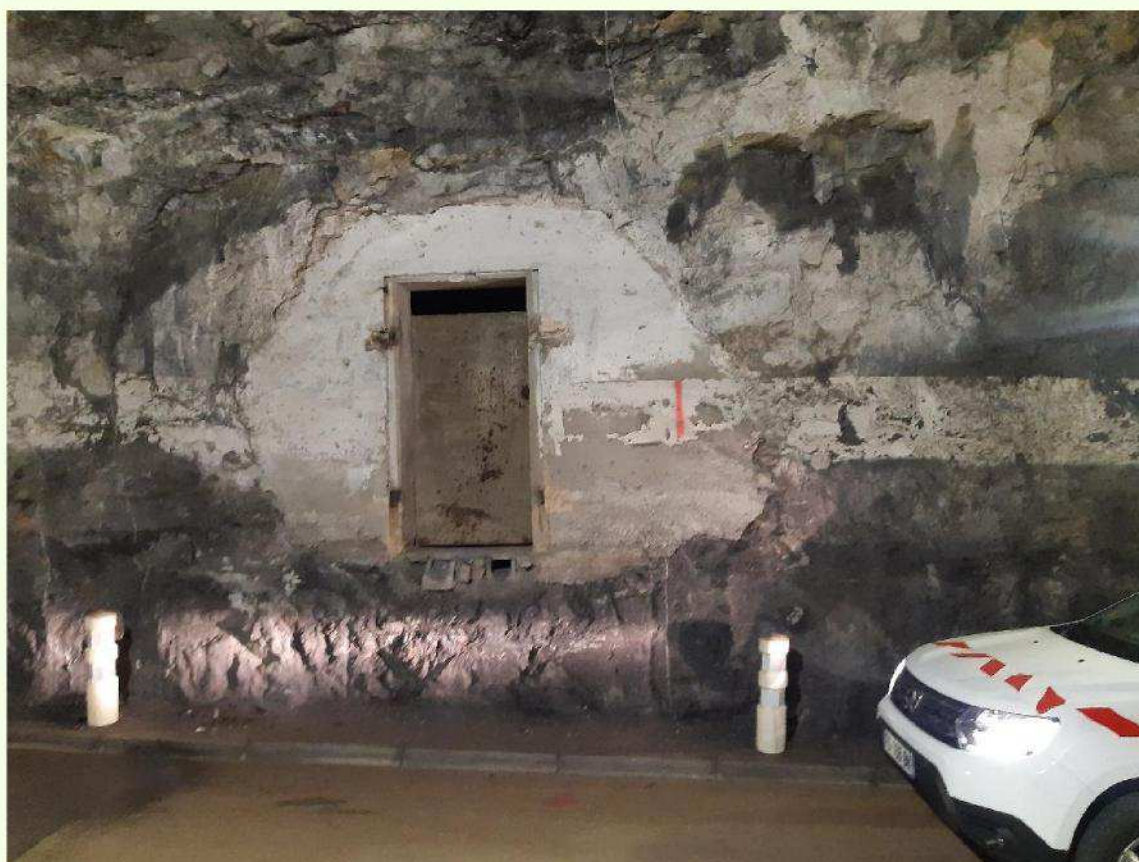
Figure 2 : Accès chambre de minage Est @AgenceRoutièreCians/Var
