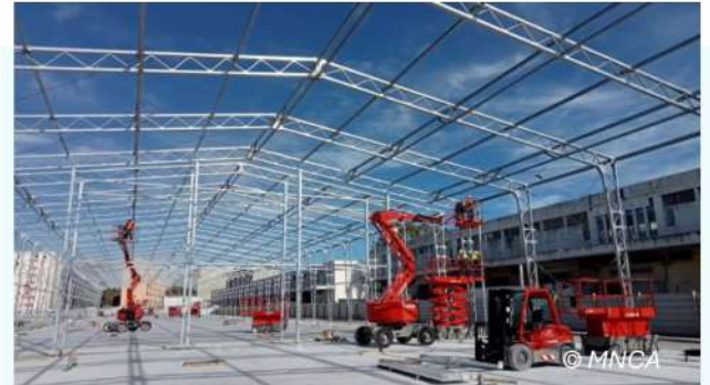
Construction du MIN provisoire de Nice
