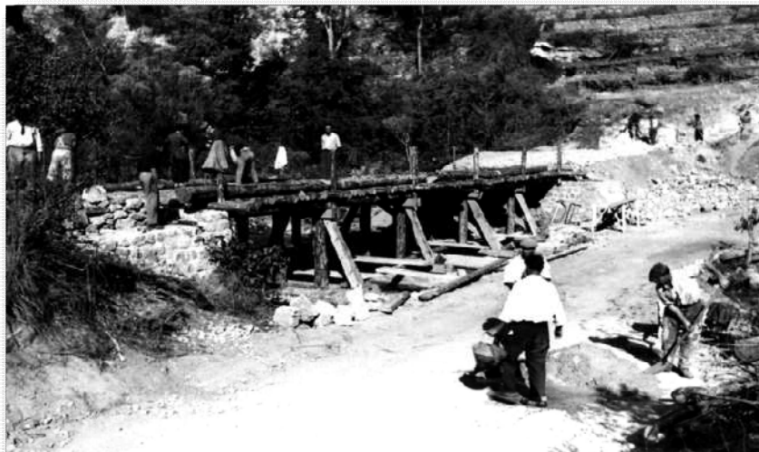
Reconstruction de pont sur la Siagne par les travailleurs de la MOI, Arch. dép. Alpes-Maritimes, 248 J 1
